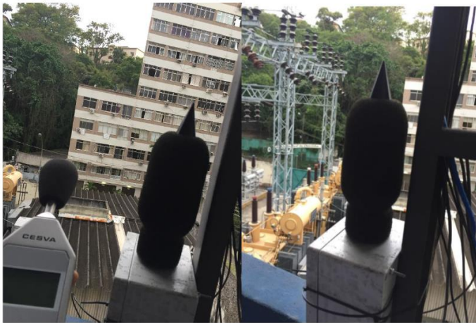
Figura 7A: Ponto de medição contínua 1 com o monitoramento de todo o período com estação de monitoramento do tipo 1 calibrada conforme IEC 61672 com o emparelhamento com analisador de frequências do tipo 1.
